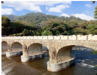
北港溪糯米橋
