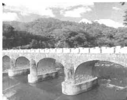
北港溪糯米橋
